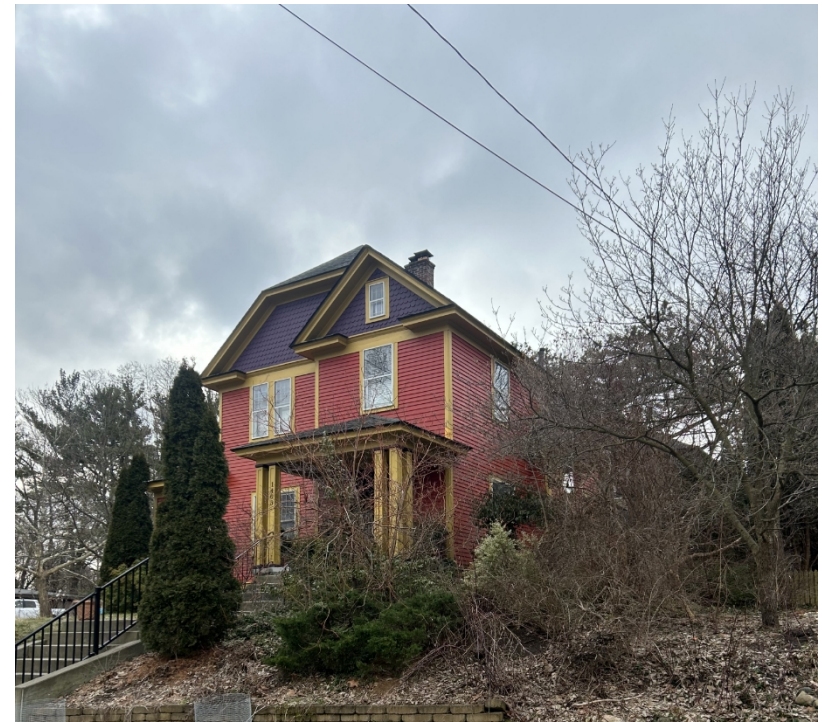
(2) 1403 Henderson looking SE
