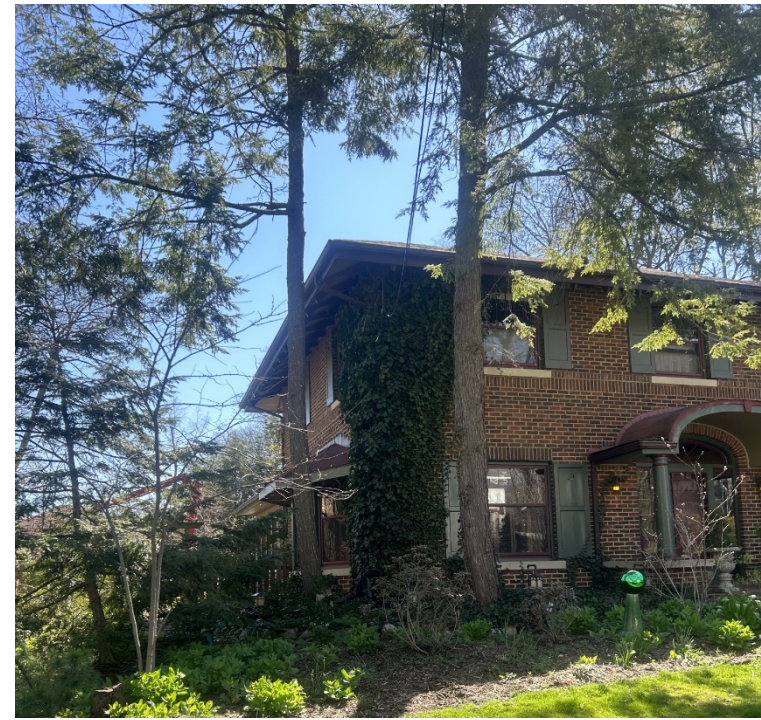
(2) 121 Bulkley looking SE
